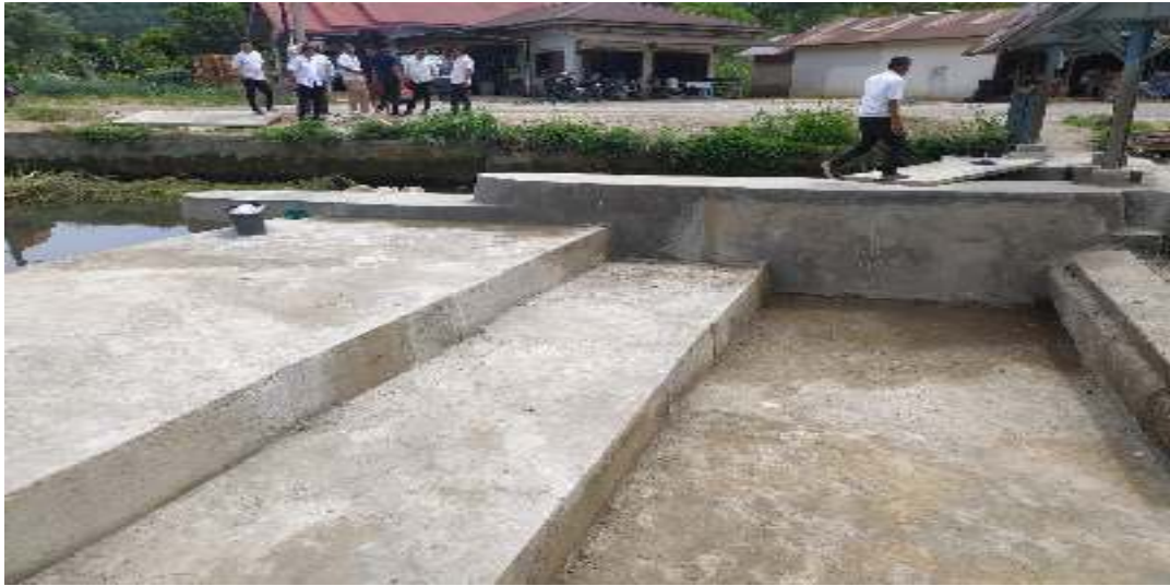
Gambar 4 Rehabilitasi jaringan irigasi permukaan DI Pinang Balirik Nagari Sungai Antuan Kecamatan Mungka
