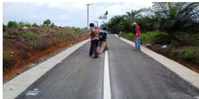
Gambar 9 Rekonstruksi jalan Gurun ke TPA Kec. Gunuang Omeh
