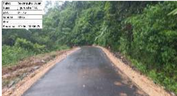
Gambar 8 Rekonstruksi jalan Gurun ke TPA Kec. Gunuang Omeh
